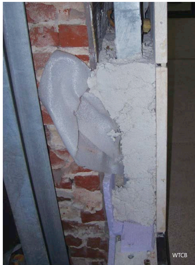
3 | Versterking van de geventileerde spouw.
