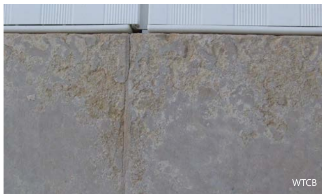
1 en 2 | Voorbeelden van kalksteen die aangetast is door te zacht water, mogelijk door een onregelde waterbehandeling.
