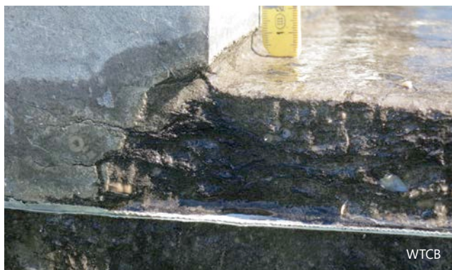
1 en 2 | Voorbeelden van kalksteen die aangetast is door te zacht water, mogelijk door een onregelde waterbehandeling.
