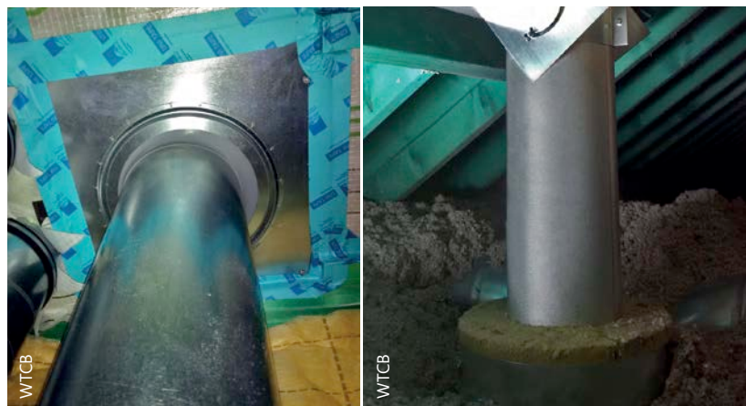
2 | Specifieke toebehoren die de continuïteit van de luchtdichtheid en de thermische isolatie waarborgen.
