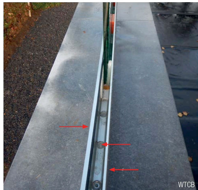
6 | Balustrade met inklemmingsprofielen zonder bevestigingsflens met aanduiding van de mogelijke infiltratiewegen.
