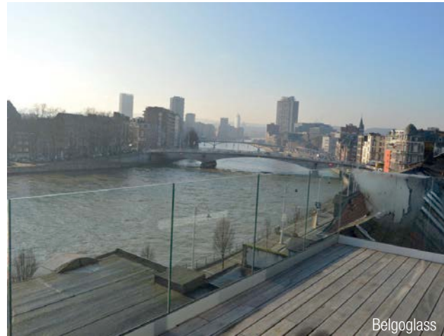
5 | Balustrade met continue inklemmingsprofielen.
