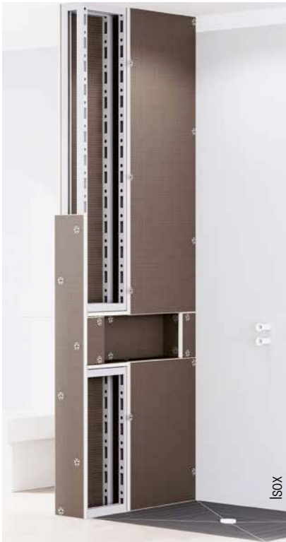
2 | Bouwplaten op regelwerk.
