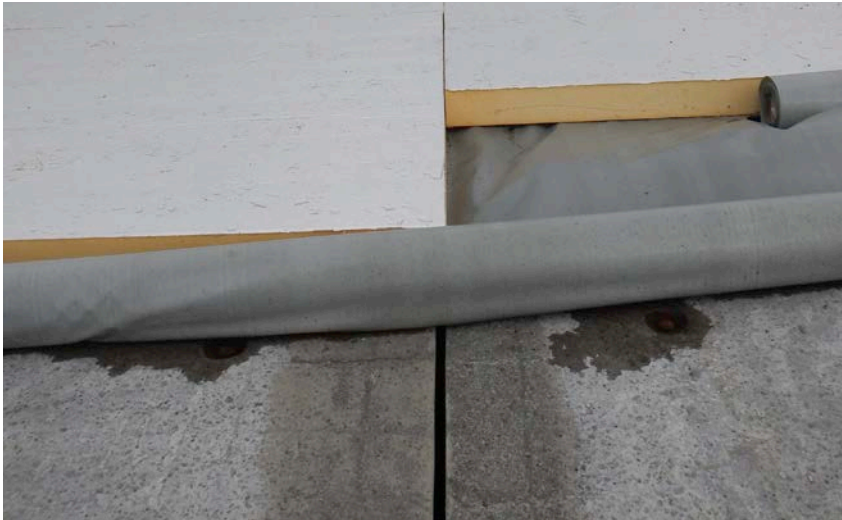
2 | Uitvoering van het dampscherm op TT-elementen.
