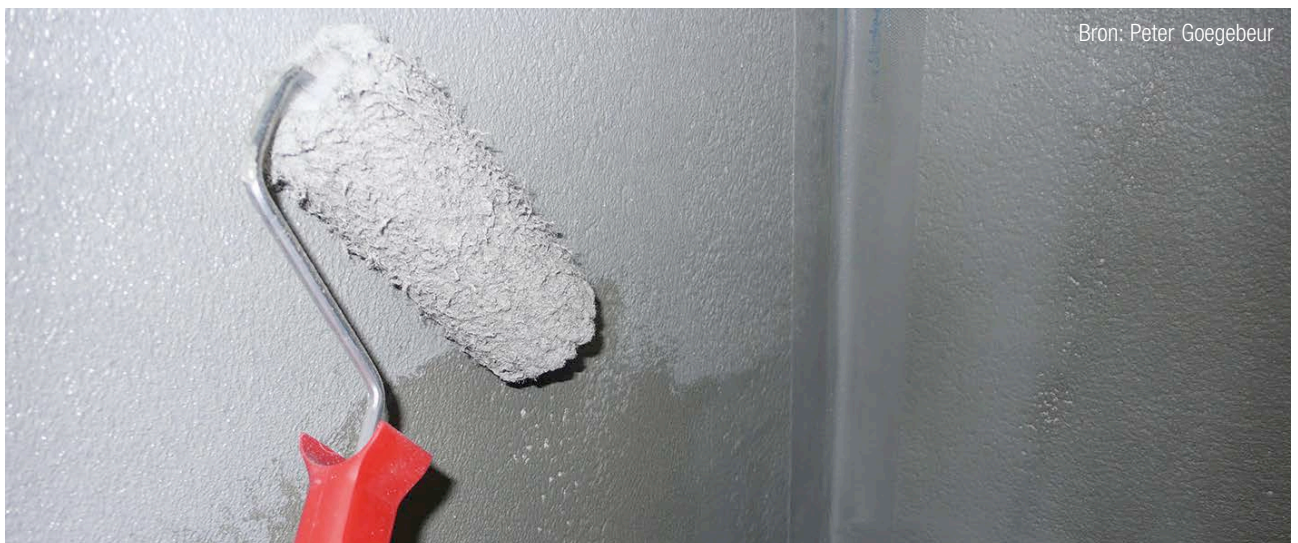
1 | Aanbrengen van een vloeibaar afdichtingsproduct.
