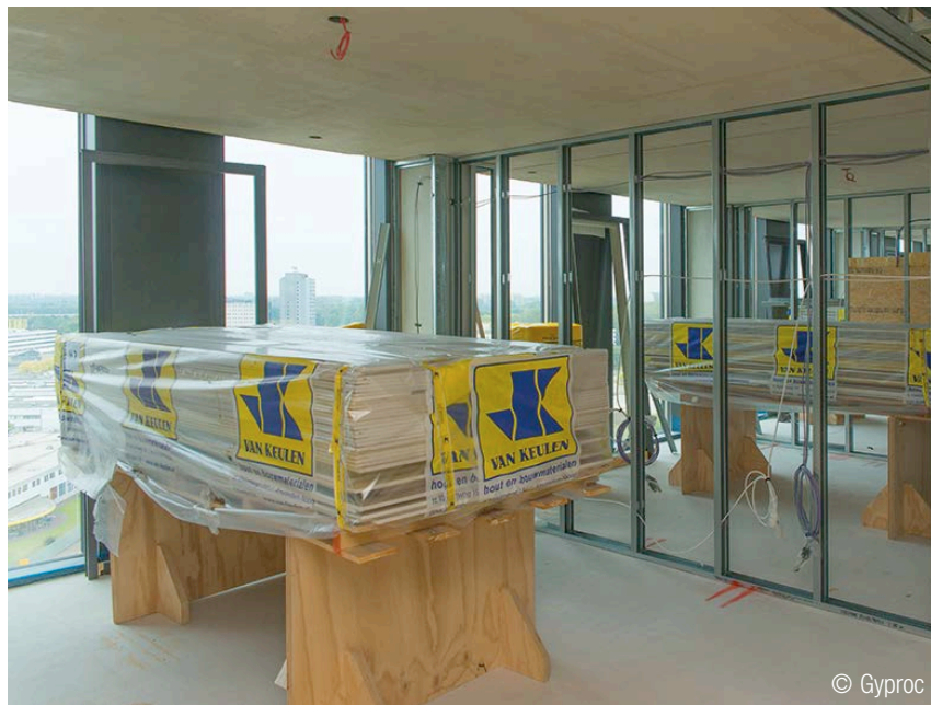
2 | Materiaalpakketten met reeds op maat gesneden platen, die dankzij de informatie uit het digitale model per ruimte samengesteld kunnen worden.
