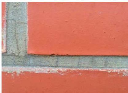
1 en 2 | Krimpscheurtjes in de voeg van een betegeling en een metselwerk
