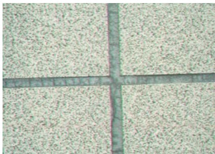
1 en 2 | Krimpscheurtjes in de voeg van een betegeling en een metselwerk
