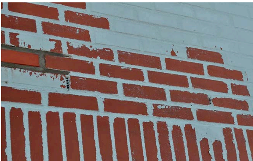
1 | Typisch uitzicht van de op de verschillende werven vastgestelde hechtingsproblemen van de verf
