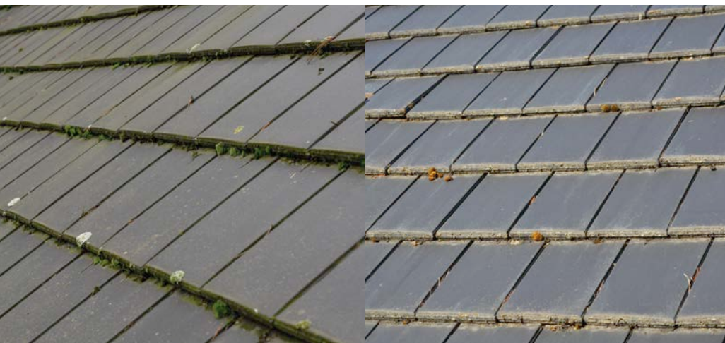
1 | Pannendak vóór (links) en één week na (rechts) de toepassing van een enzymatisch product
