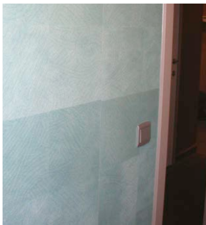
2 | Bij sommige patronen is het niet evident om een 'vlekkeloze' overgang te realiseren tussen de verschillende stroken
