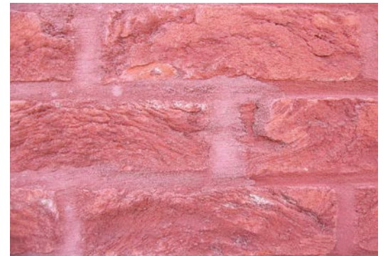
3 | Kleurverschillen in de voegen
