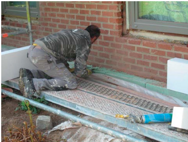
3 | Uitvoering van een gevelvoetisolatie.
