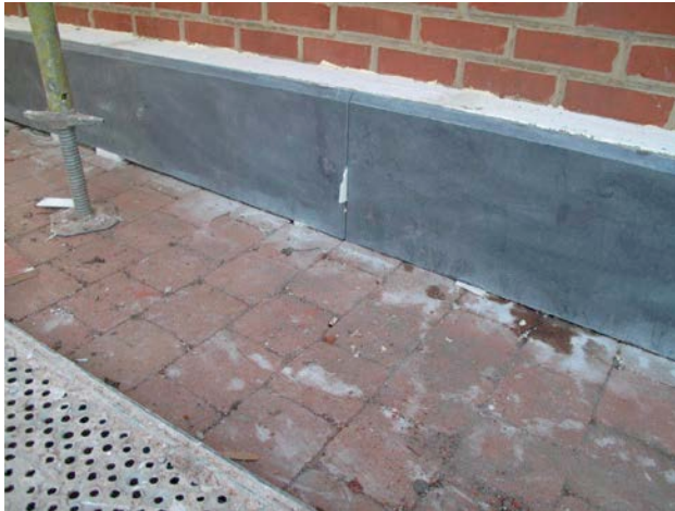
2 | Plaatsing van een ondermuur.
