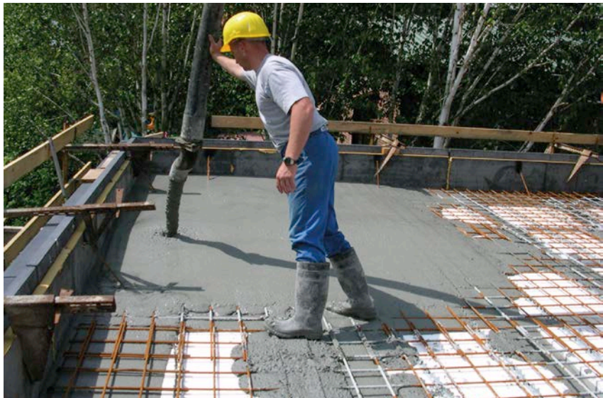
2 | Bij de bestelling van zelfverdichtend beton dient minstens de vloeimaat ( slump flow ) gespecificeerd te worden
