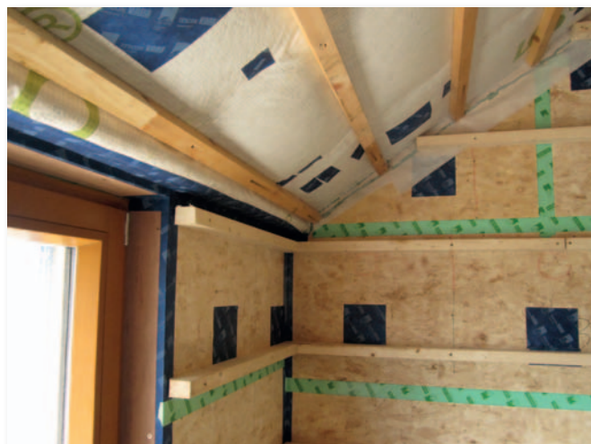
Afb. 1 De voegen en perforaties in de houten binnenbeplating worden afgedicht met kleefband.
