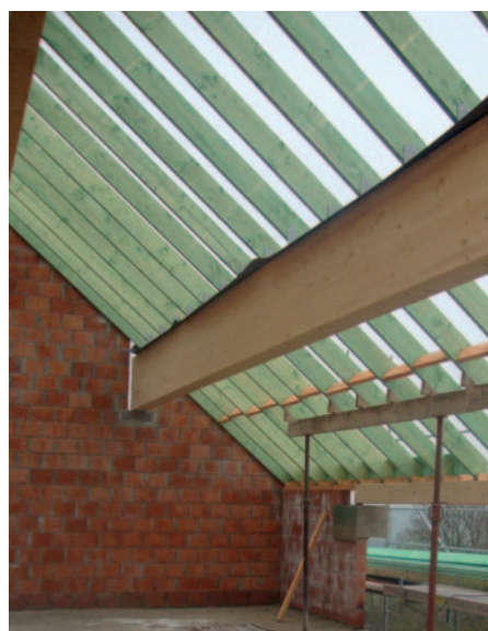
Afb. 5 Detail dat een aangepaste coördinatie vereist : de wachtfolie wordt op de gordingen geplaatst, waarna het timmerwerk gemonteerd wordt. Vervolgens sluit men deze wachtfolie aan op het dampscherm om de continuïteit van het luchtscherm over het volledige dakschild te waarborgen.
