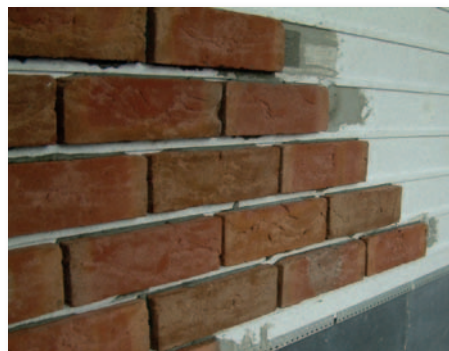
In situ verlijmd steenstrips op de isolatie.
