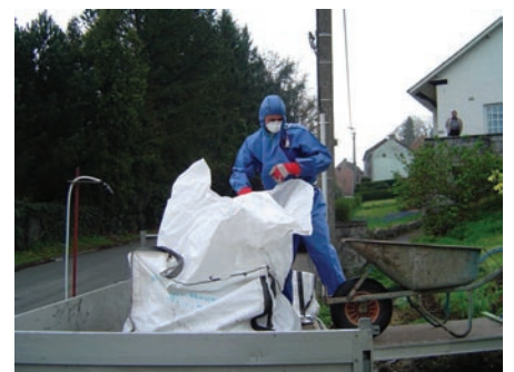
Afb. 3 Uitkieperen van de kruitwagen in de speciale zak.
