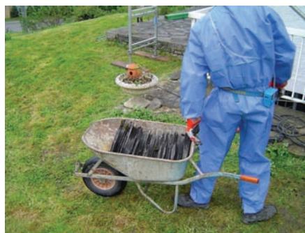
Afb. 2 Transport van het asbestcement met een kruitwagen.
