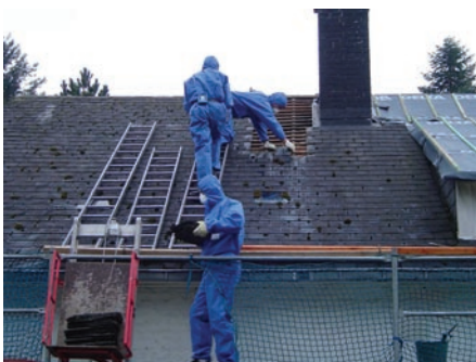
Afb. 1 Ontmanteling van elementen uit asbestcement in open lucht.
