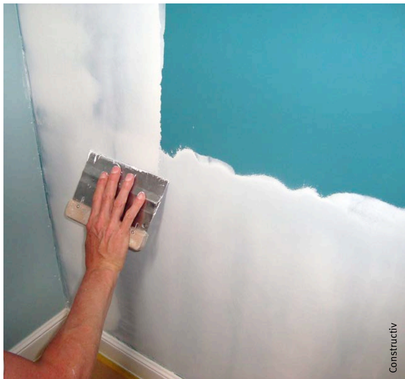
Afb. 3 Aanbrengen van schildersplamuur met behulp van een plamuurmes.
