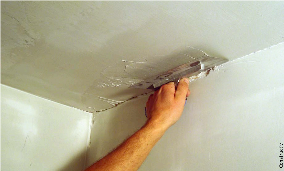
Afb. 5 Aanbrengen van schildersplamuur met behulp van een spatel.
