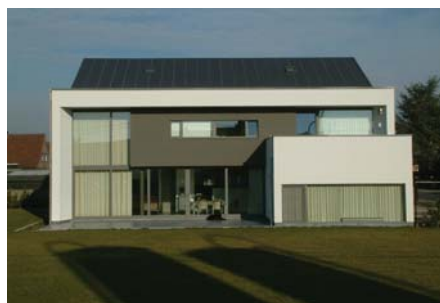
Bepleistering op isolatie op de gevel van een woning.
