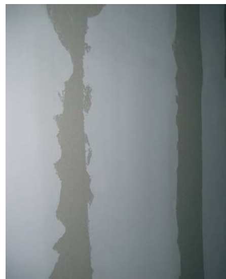
Afb. 1 Uitvoering van een opvoeging volgens de afwerkingsgraad Q2.
