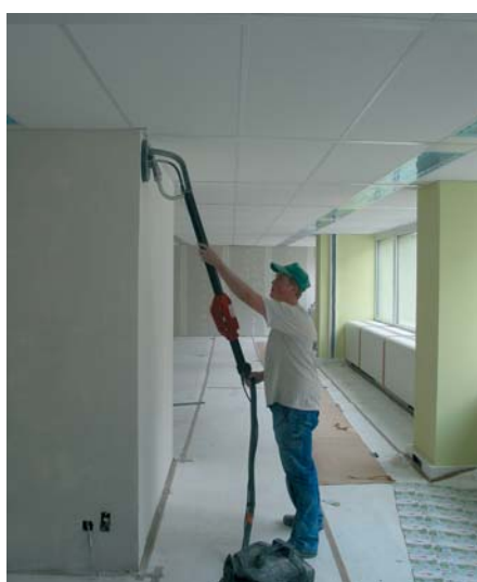
Afb. 2 Soms kan het nodig zijn het oppervlak af te schuren.
