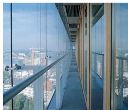
Afb. 2 Dubbele gevel op meerdere verdiepingen, op natuurlijke wijze geventileerd met buitenlucht.
