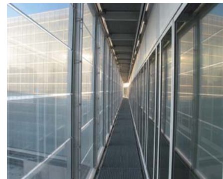
Afb. 2 Dubbele geventileerde gevel.
